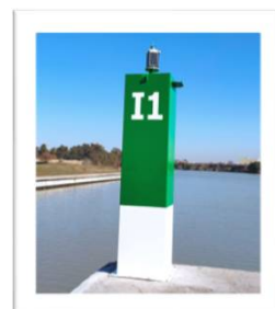
Baliza I1 (09991.14) Posición: 37 19,183N 6 00,195W Apariencia: CtV 1s Característica: L0,25 oc0,75 Alcance nominal: 3mn
