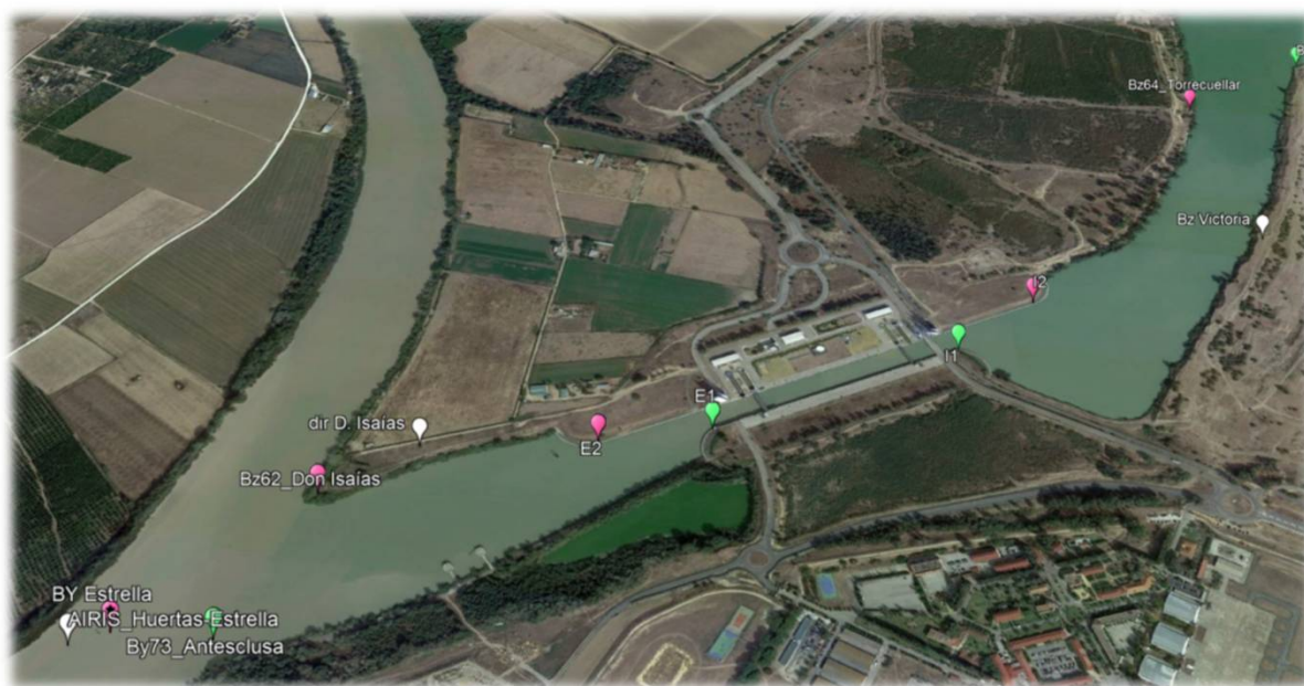
Planta de balizamiento en la esclusa Puerta del Mar.
