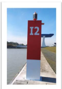
Baliza I2 (09991.16) Posición: 37 19,251N 6 00,094W Apariencia: CtR 1s Característica: L0,25 oc0,75 Alcance nominal: 3mn
