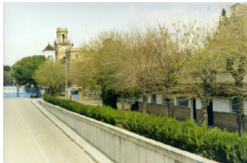
▼ FOTO 23. ZONA DE SERVICIO INTERNO PORTUARIO
