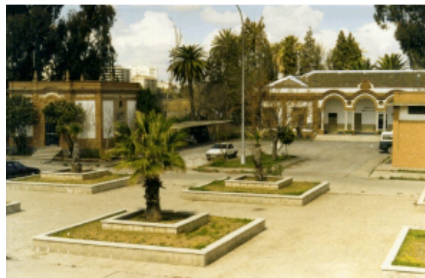
▼ FOTO 12. ZONA DE SERVICIO INTERNO PORTUARIO
