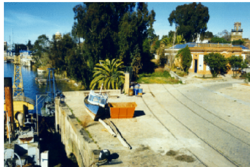
▼ FOTO 24. ZONA DE SERVICIO INTERNO PORTUARIO
