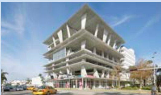
31. Car Park. Herzog & De Meuron. Miami (EEUU)
