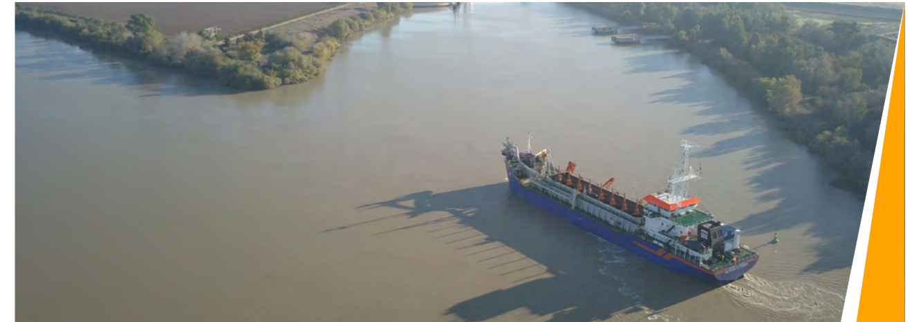
Dragado de mantenimiento de la canal de navegación.
