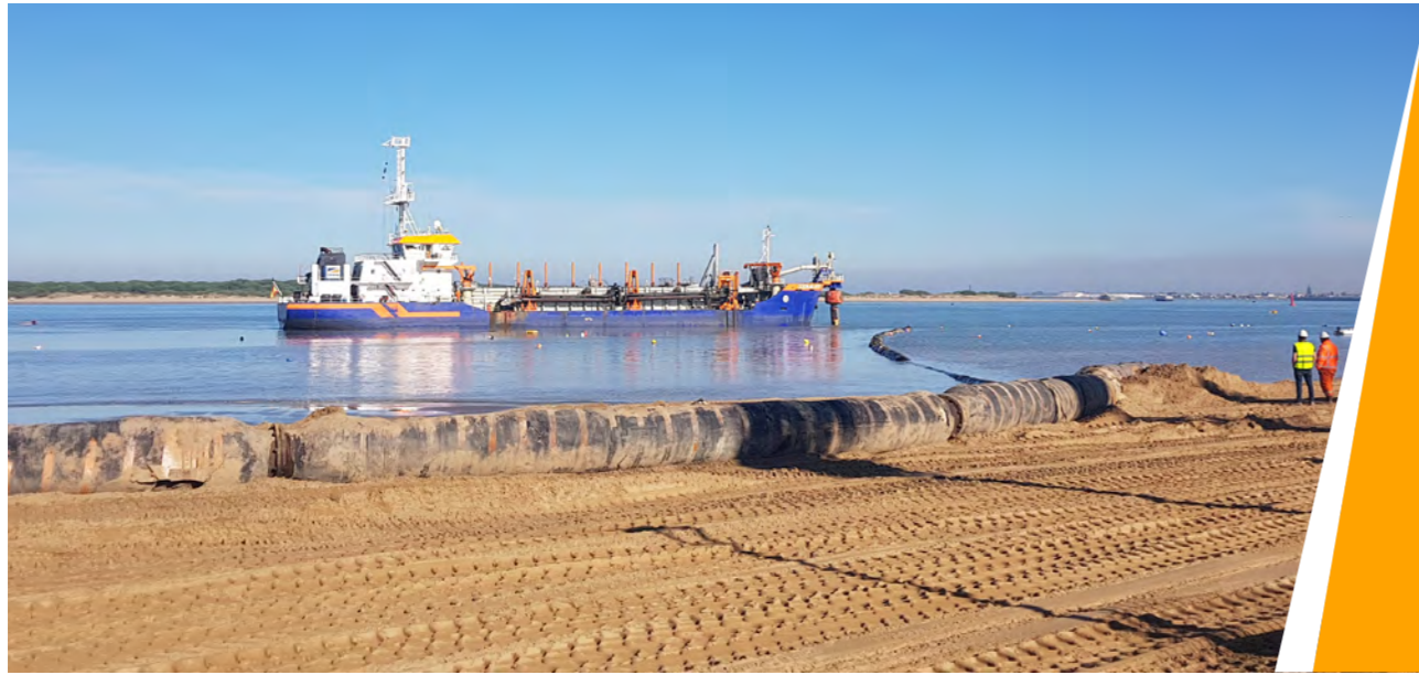
Arenas depositadas para regenerar las playas de Sanlúcar de Barrameda.
